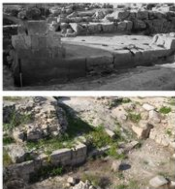
Abb. 5 Unten: Mauerwerk in Samaria (Foto: April 2016). Oben: Aufwendiges Mauerwerk in Ramat Rahel.
