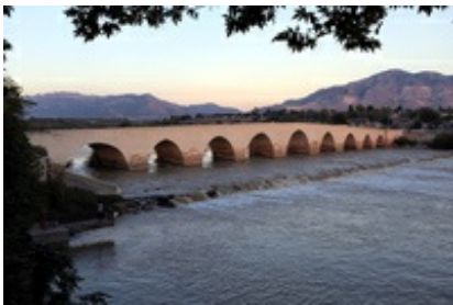
Abb. 4 Die ursprünglich römische Brücke über den Pyramos (Ceyhan) bei Mopsuestia (Misis).
