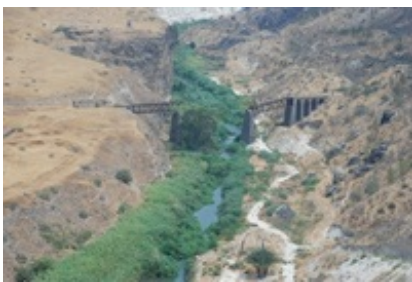
Abb. 9 Yarmūk, Mittellauf mit Eisenbahnbrücke.
