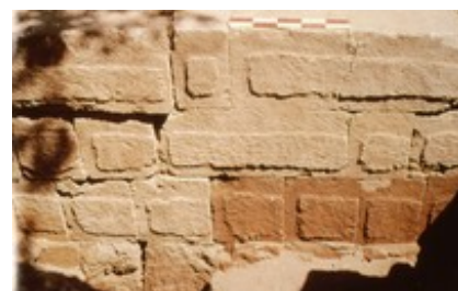
Abb. 16 Steinquader mit Spiegelschlag in „Läufer-Binder“-Technik gesetzt (Tel Dan; Eisenzeit II).
