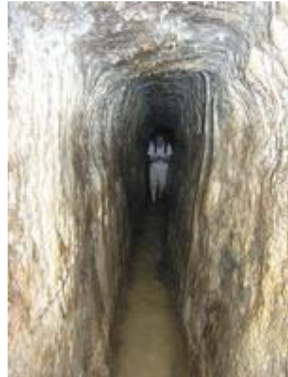
Abb. 20 Der Siloa-Tunnel, den Hiskia bauen ließ.
